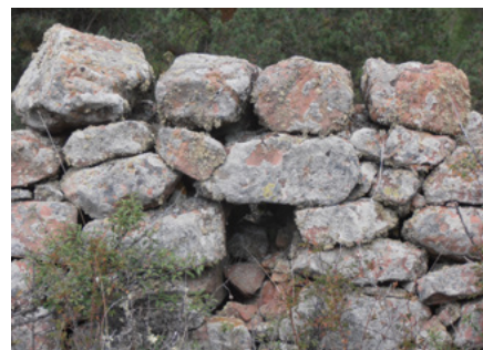
Muro de piedra seca resiliente | foto Luis A. Sáez
